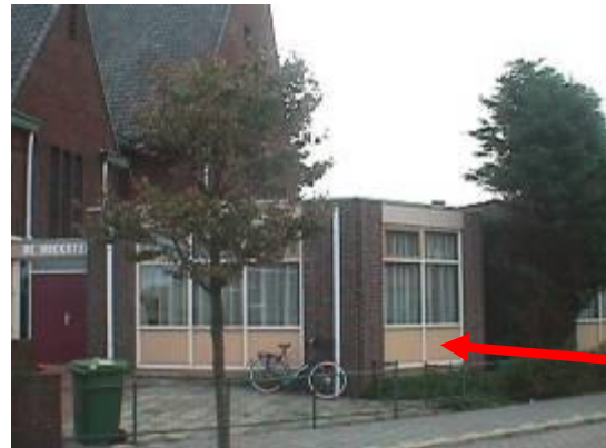
foto 22: asbesthoudende gevelbeplating.
