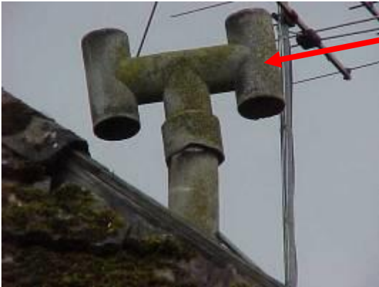
foto 31: asbestcement H-stuk.
