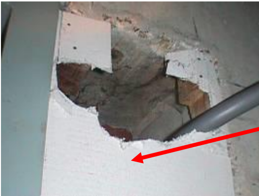
foto 25: asbesthoudende beplating bij doorvoeren.
