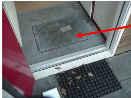
foto 34: asbesthoudend vloerluik.
