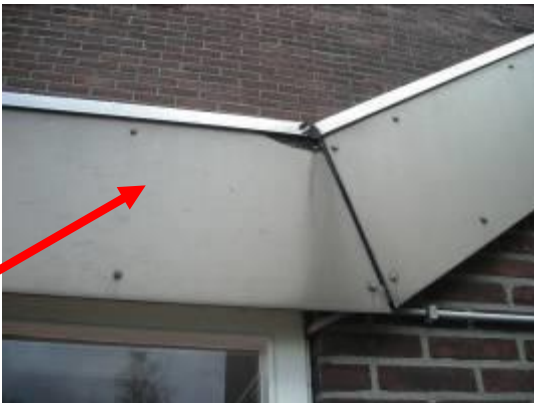
foto 21: asbesthoudende boeiborden.
