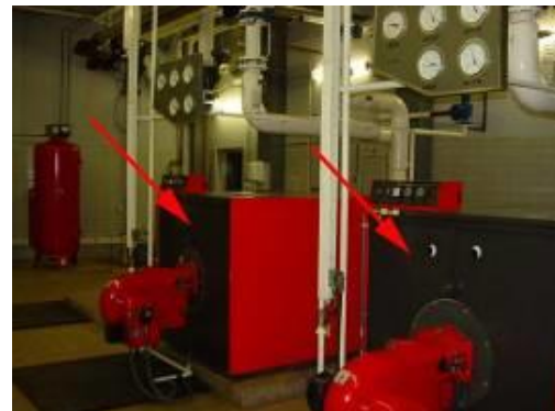
foto 24: CV-ketels die asbesthoudende onderdelen kunnen bevatten.
