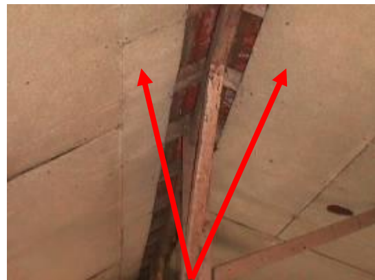
foto 28: asbesthoudend dakbeschot.
