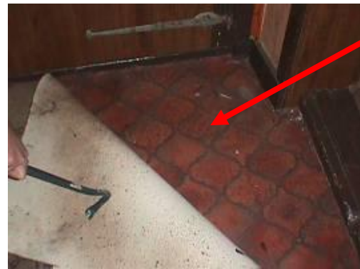
foto 36: asbesthoudend vloerzeil.
