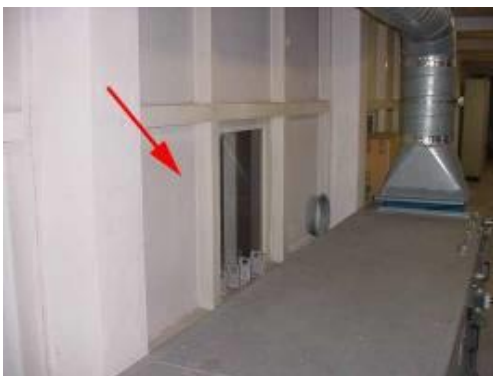
foto 17: asbesthoudende wandbeplating.
