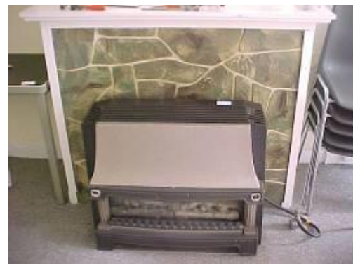
foto 18: asbesthoudende sierbeplating.
