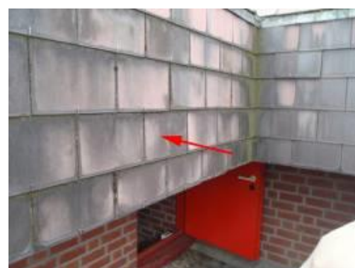
foto 29: asbesthoudende dakleien.
